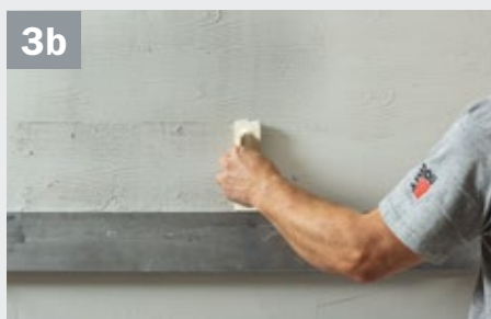
3b Na vytvorenie efektu dreva v čerstvo nanesej omietke je možné použiť aj gumennú štruktúrovaciu špachtľu-Maserboy.
