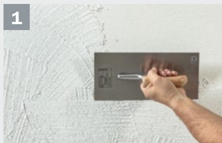
1 Baumit CreativTop Fine naniesť celoplošne antikorovým hladidlom a stiahnuť na hrúbku zrna.
