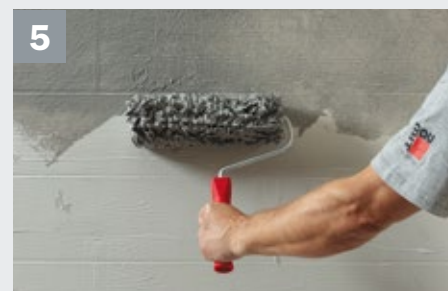
5 Naniesť prvú, druhú prípadne tretiu vrstvu Baumit Lasur v závislosti od požiadavky na výslednú sýtosť odtieňa.
