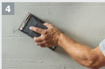
4 Po vyschnutí (min. 1 deň*) pre zvýraznenie efektu dreva vytvoriť vodorovné a zvislé drahky medzi jednotlivými doskami. Drobné výstupky po otláčaní je možné prebrúsiť brúsny papierom P80 alebo K16.
