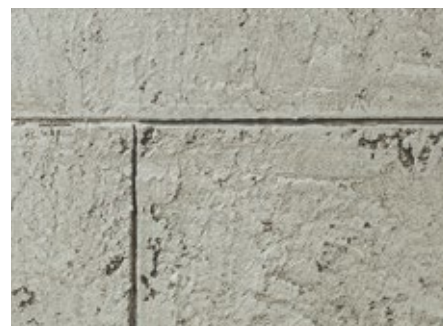
Betón hrubý | Beton rough
