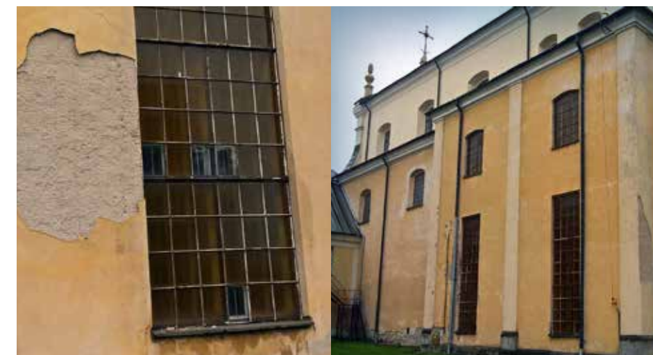
Wygląd fasady Zespołu Klasztornego Ojców Pijarów przed gruntowną odnową za pomocą tynków renowacyjnych i farb firmy Baumit.
