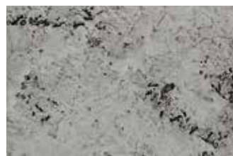
10 τεχνική άγριας όψης σκυροδέματος
