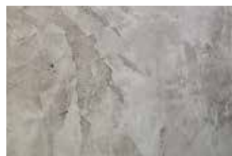
11 τεχνική λείας όψης σκυροδέματος
